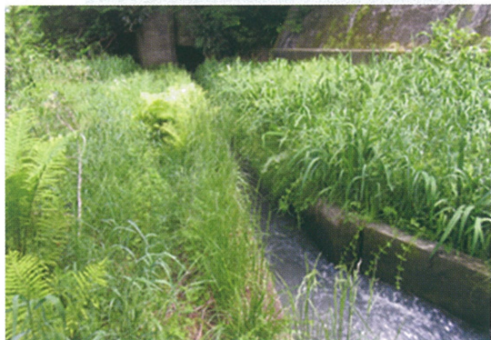
現在の取水口付近 (原町区錦町付近)
