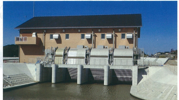
小沢排水機場
