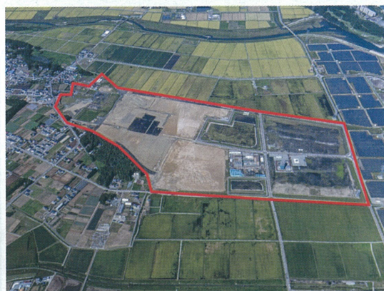
原町東地区ほ場整備区域内の復興工業団地
