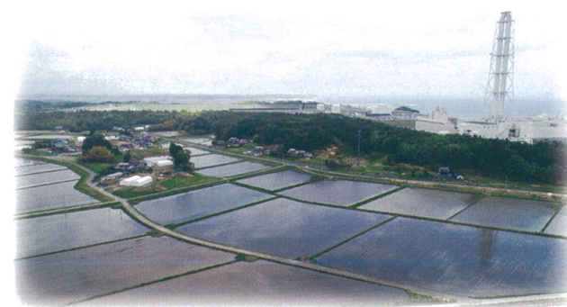
基盤整備後の大区画ほ場(金沢・北泉地区)
