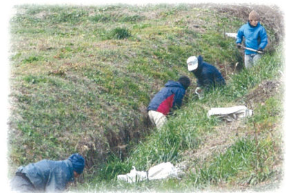
▲水路泥上げ作業 (大原)
