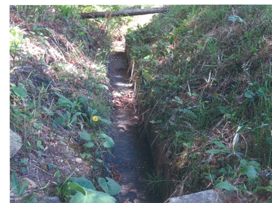
大迫堤に通水していた掛入堀(矢川原地区)
