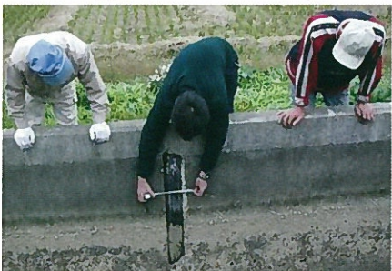
施設の軽妙な補修
