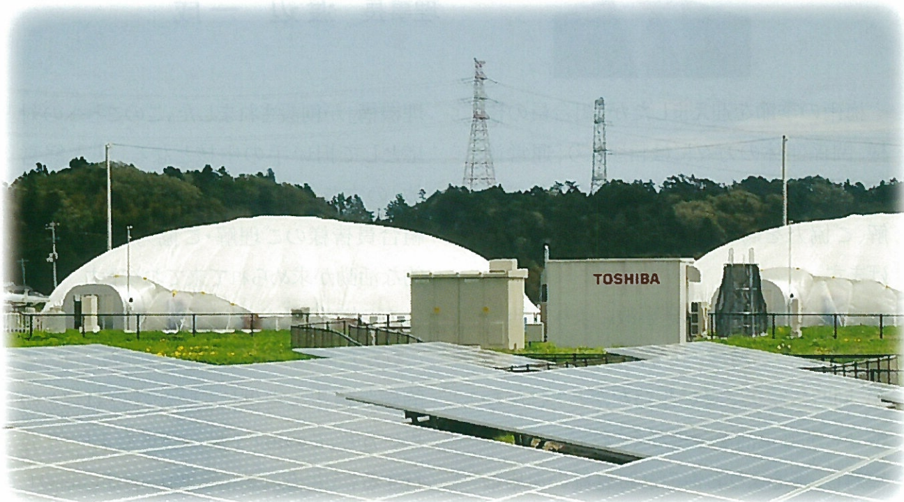
南相馬ソーラー・アグリパーク(ドーム型植物工場、太陽光パネル)
