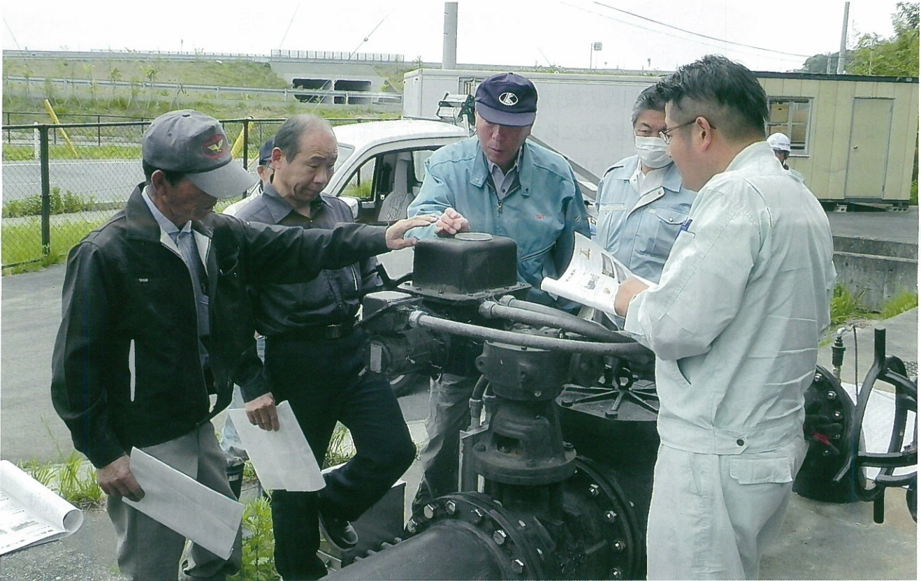
関ノ内揚水機場施設整備の状況
