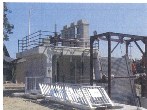
▲太田排水機場外観(撮影時5月中旬)
