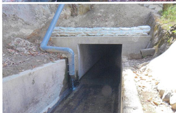
◀隧道補修工事後
