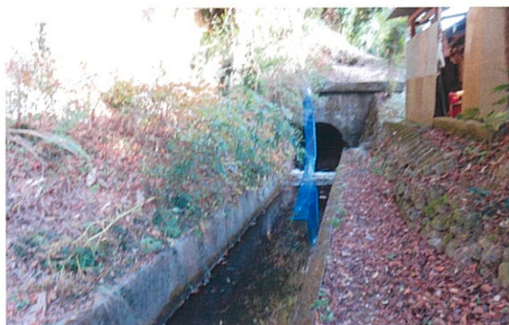
◀隧道補修工事前
