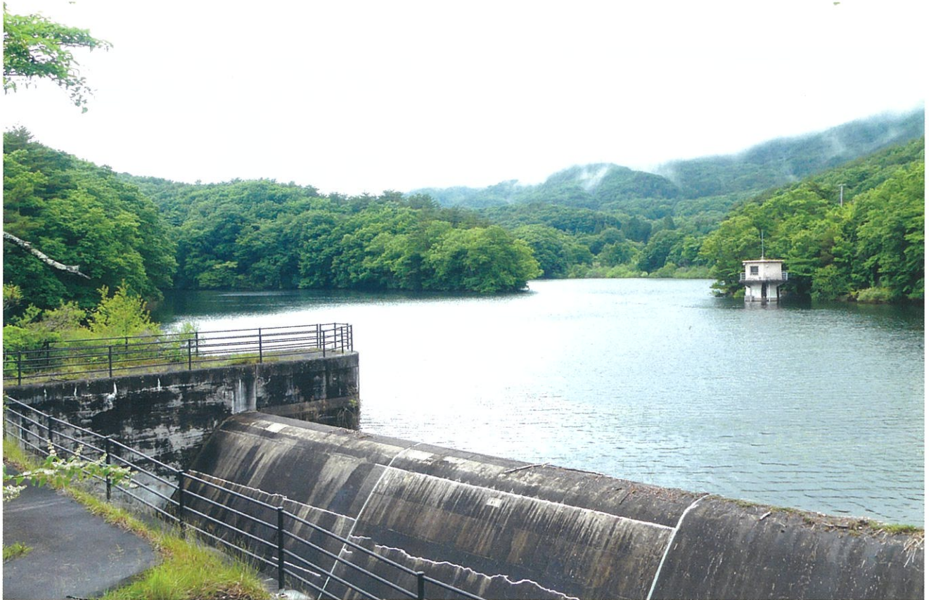
▲岩部ダム(飯館地区)撮影6月中旬
