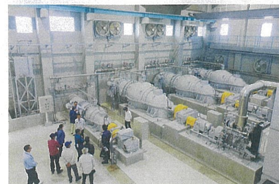
▲小沢排水機場内部視察の様子
