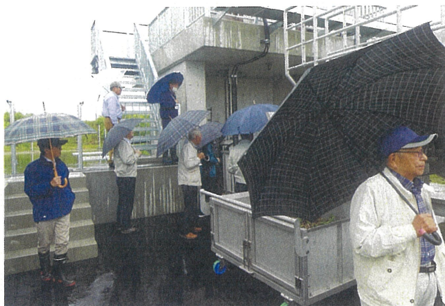
▲須賀内排水機場視察の様子(泉地区)
