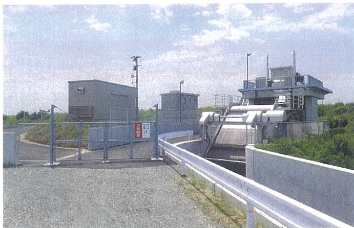
▲須賀内排水機場外観
