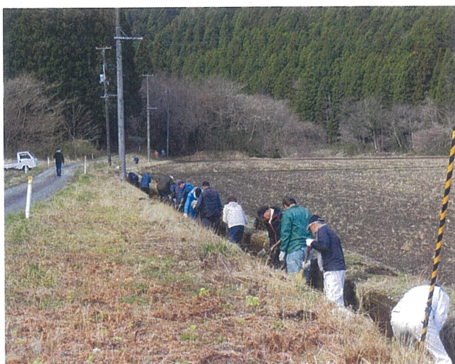
▲水路泥上げ作業の様子（大谷地区）
